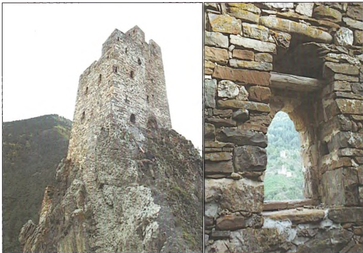
Рис. 8. Сел. Вовнушки. D49A. Слева – общий вид, справа – образец D49A 6 со 53 годичными кольцами (сосна).
