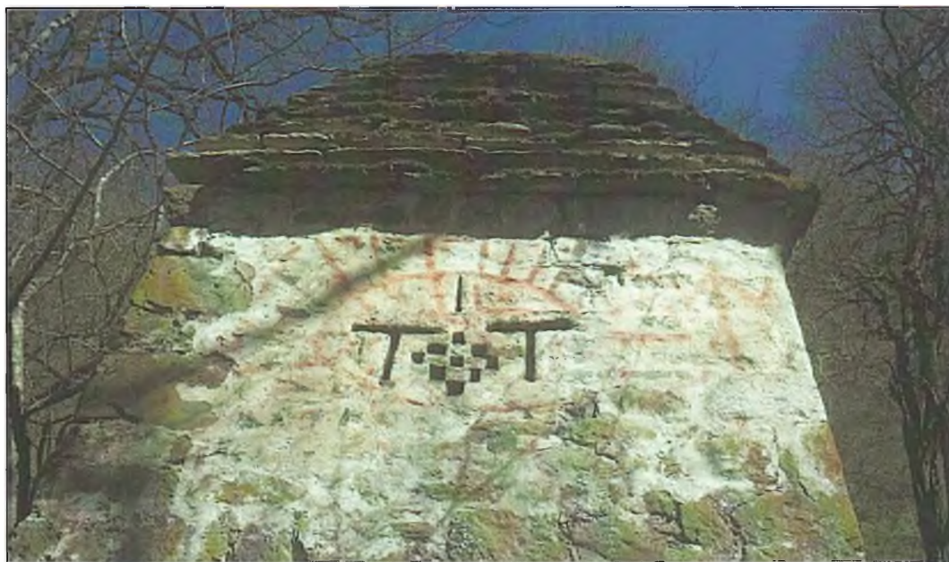
Имар – надземный склеп у замка МужгИоне на правом берегу р. Фортанга. Здесь, в «обители Иэл» покоятся «души предков» местной фамилии. На фасадной стене склепа тИговзанч умелой выборкой камней сотворил оригинальный рисунок, в котором заложен некий скрытый смысл. Этот загадочный символ охристой краской, нанесенной на известковую штукатурку, заключен в солярный круг – гадоахарг, от которого отходят ткььо /«двадцать»/сакральных для галгайцев лучей. Справа от круга начертан стилизованный рисунок человека, стоящего в позе адорации. В этой сложной композиции символов несомненно отражены древние представления галгайцев о тесном взаимодействии обитателей Даьла Маьлхе и Даьла Иэл, потомков и предков. (Фото автора).
