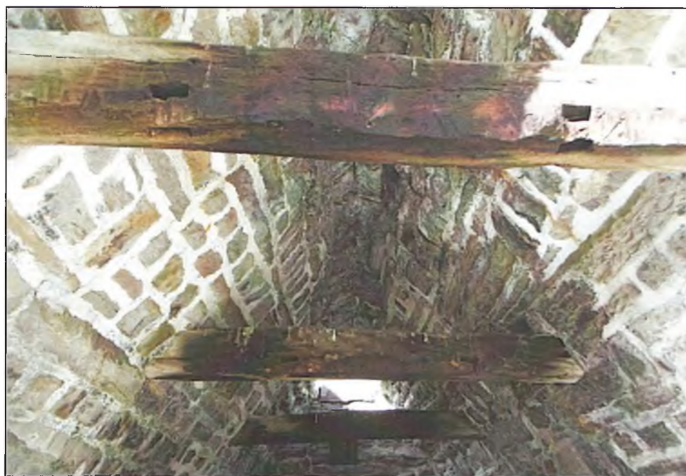
Рис. 7. Сел. Оздиче. D48A. Верхнее фото – общий вид на склеп и башни, нижнее – три дубовые балки склепа, из которых взяты образцы: начиная с ближней - D48A 3 (89 колец), D48A2 (59 колец), D48A1 (40 колец).
