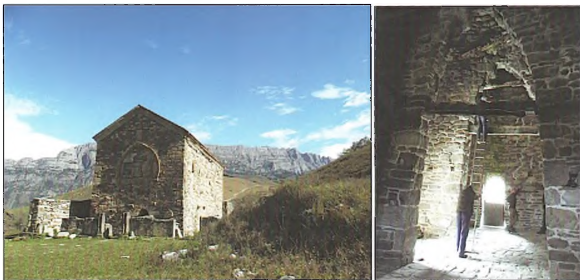
Рис. 9. Храм Тхаба-Ерды. D50A. Слева – общий вид, справа – отбор образца D50A6 (78 колец). На переднем плане балка, из которой был отобран образец D50A3 (154 кольца).
