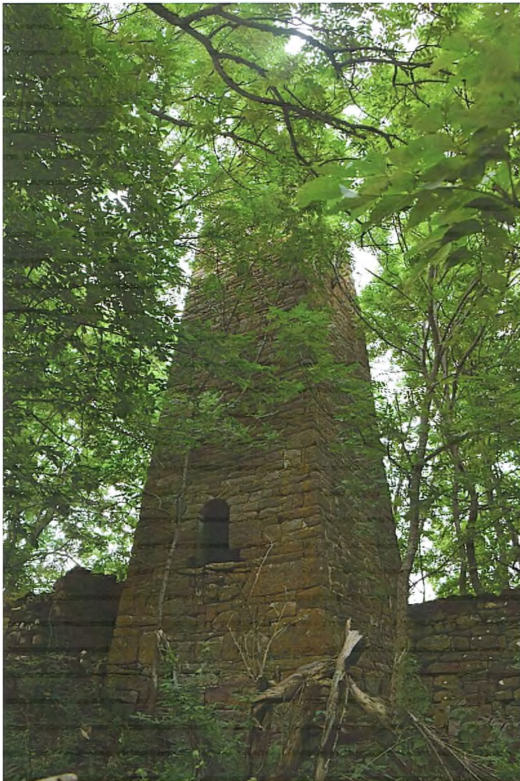
Рис.1. Боевая башня архитектурного комплекса Верхний Мешт.
