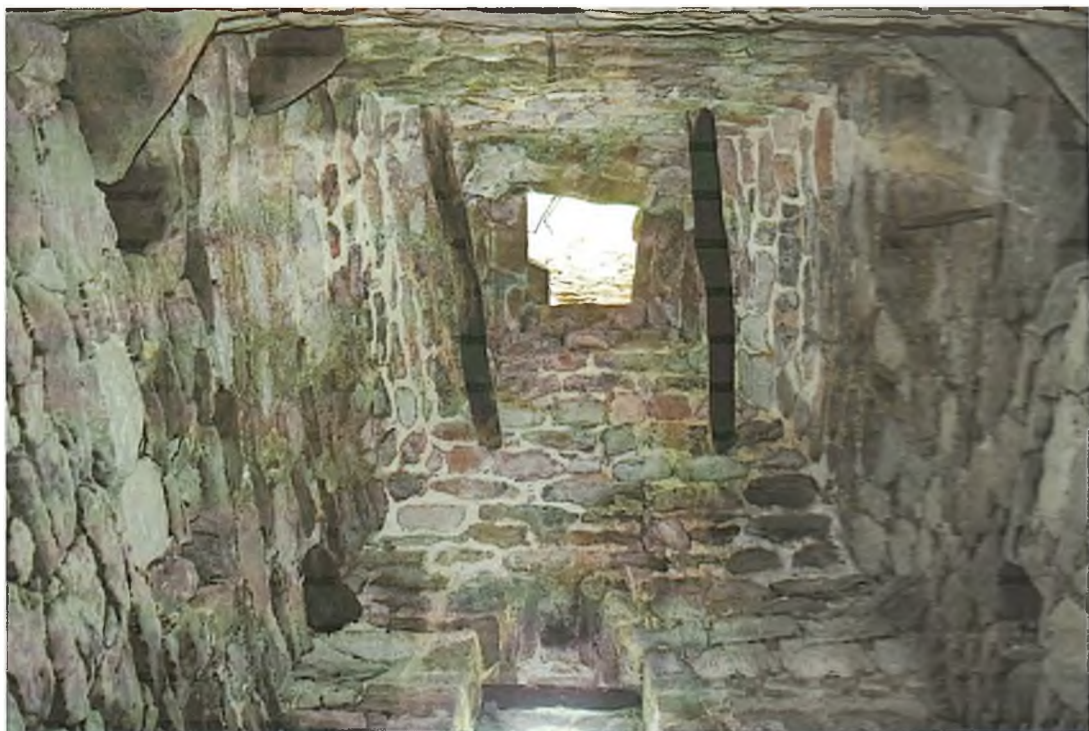
Рис.2. Боевая башня архитектурного комплекса Верхний Мешт. Интерьер. Вид на лаз в перекрытии второго этажа.
