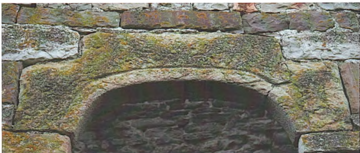
Рис. № 9. Оконный арочный проем восточной стены жилой башни с. Меллер.
